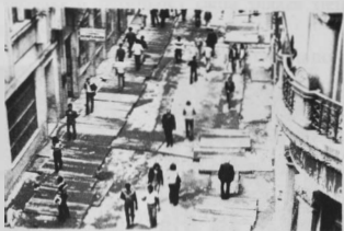
Una fase dei lavori di trasformazione.
