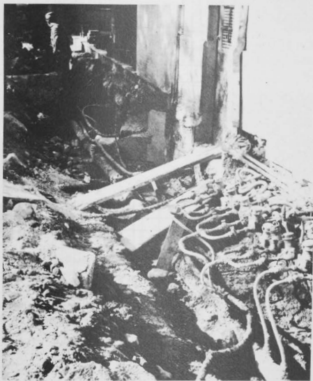
Atene - Un aspetto dei lavori di trasformazione totale di una strada da veicolare a pedonale. Il groviglio di cavi e tubazioni di ogni genere al di sotto del livello stradale per cui si è dovuto attuare un intervento di recupero totale prima di realizzare la nuova pavimentazione bene mette in luce le difficoltà incontrate.
