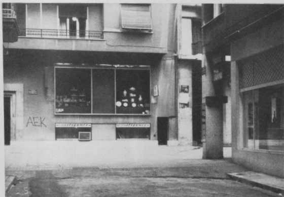
Atene - Il punto di attacco fra una vecchia stradina ed un'altra ripavimentata in relazione alle esigenze pedonali. Pur se non del tutto rifinito, l'attacco evidenzia come la nuova pavimentazione, per essere realizzata, sia stata sopraelevata rispetto alla vecchia per cui si è reso necessario in raccordo del tipo in fotografia al fine di permettere il transito ai veicoli di servizio e di emergenza (fotografia dell'autore).
